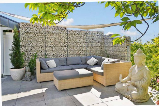
Garbionenzaun mit Steinfüllung
