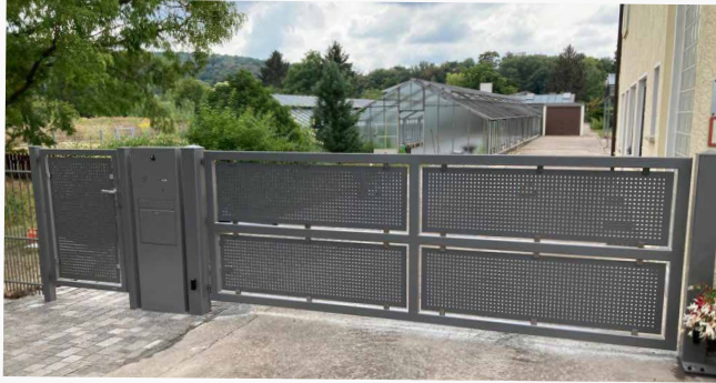
Lochblech-Zaun mit großem Eingangsbereich
